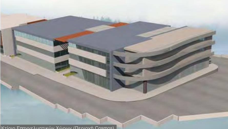
Κτίριο Επαγγελματικών Χώρων (Περιοχή Cosmos)
